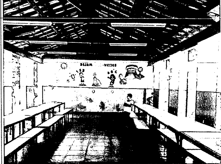
Descrição: REFEITÓRIO EXISTENTE - ESCOLA CORONEL SIMÃO CAMPOS
